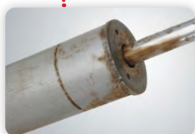
Корозія на корпусі
