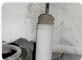
Uszkodzony, luźny odbój amortyzatora
